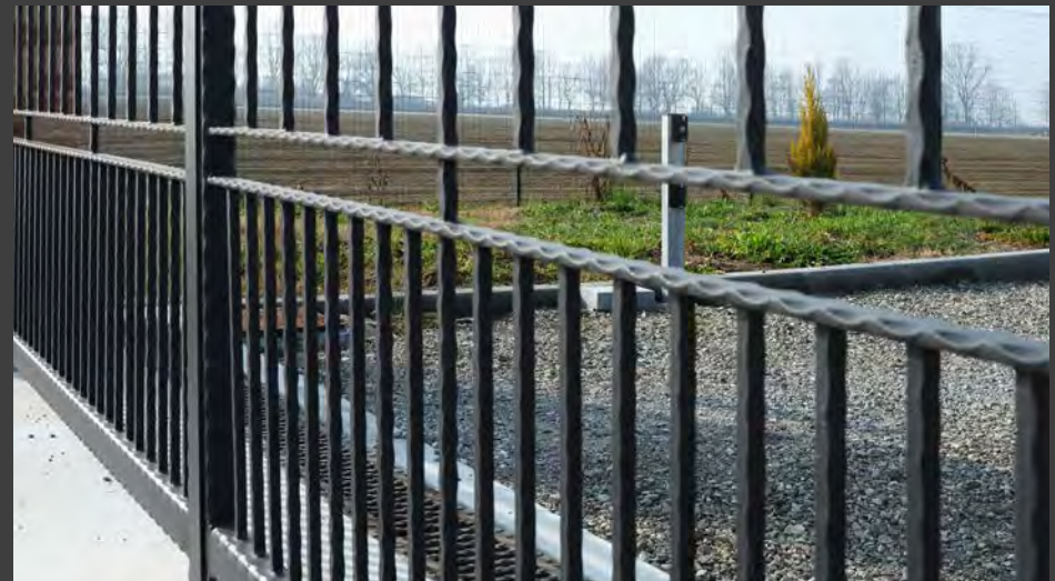
TAMPONATURA INFERIORE COMPOSTA DA ELEMENTI FORGIATI.
