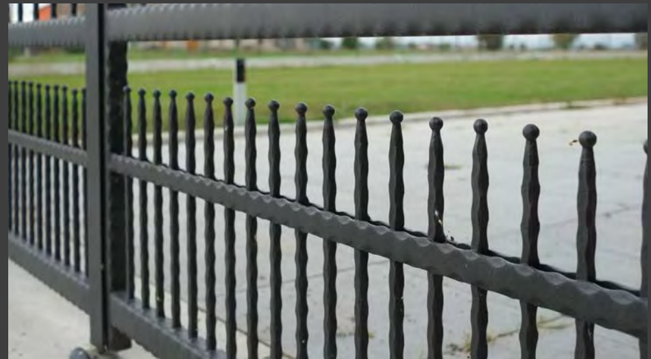
TAMPONATURA INFERIORE COMPOSTA DA ELEMENTI FORGIATI.
